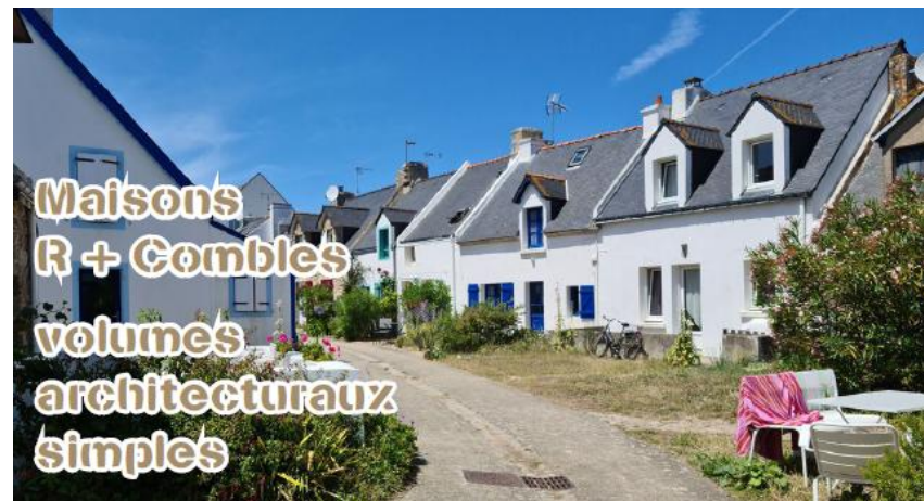
L'existant - Source : Atelier Terre A Terre pour AQTA
