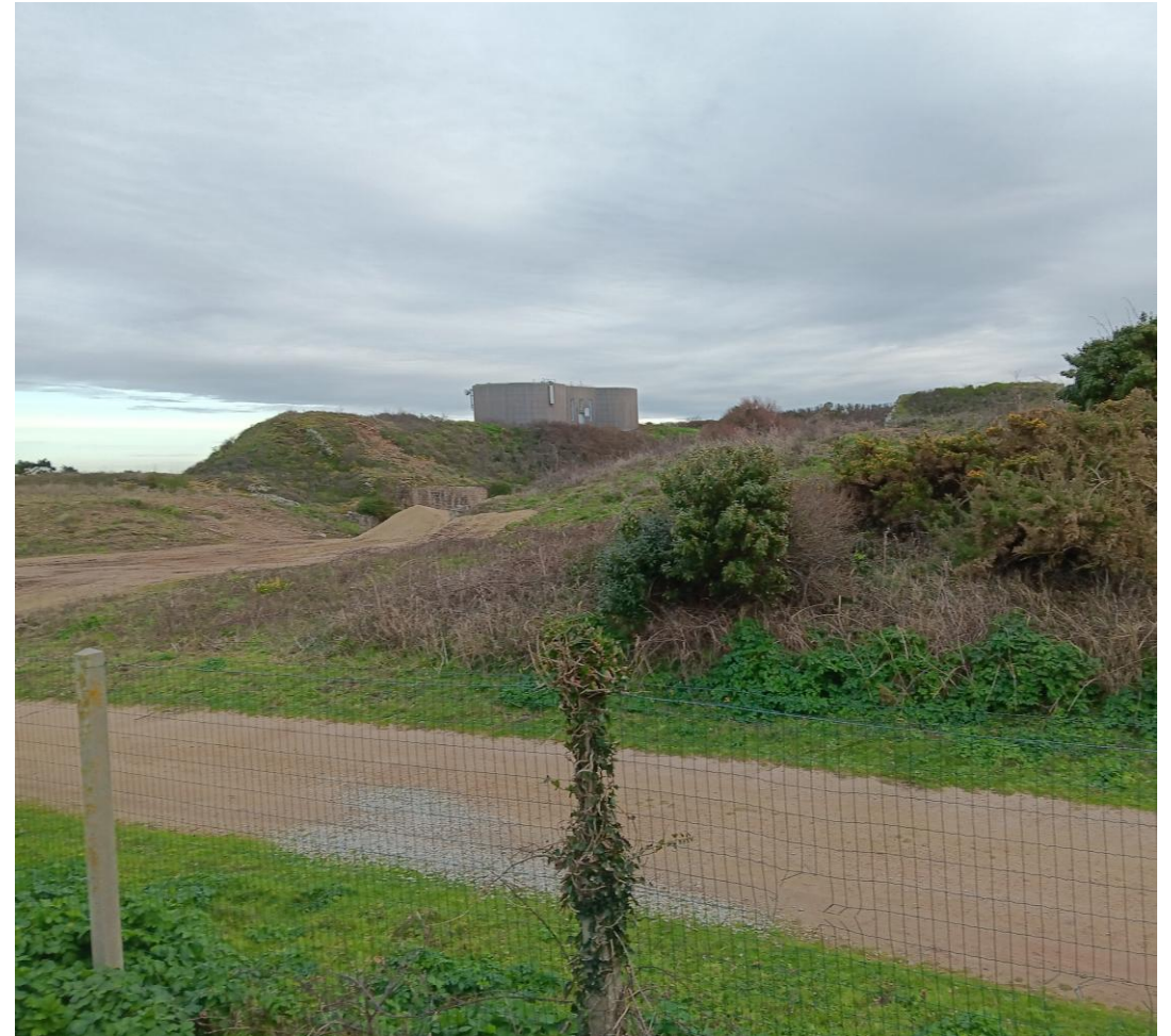
Vue sur le château d'eau depuis le site du projet – Morbihan Energies
