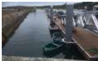
Le ponton flottant construit en 2025
