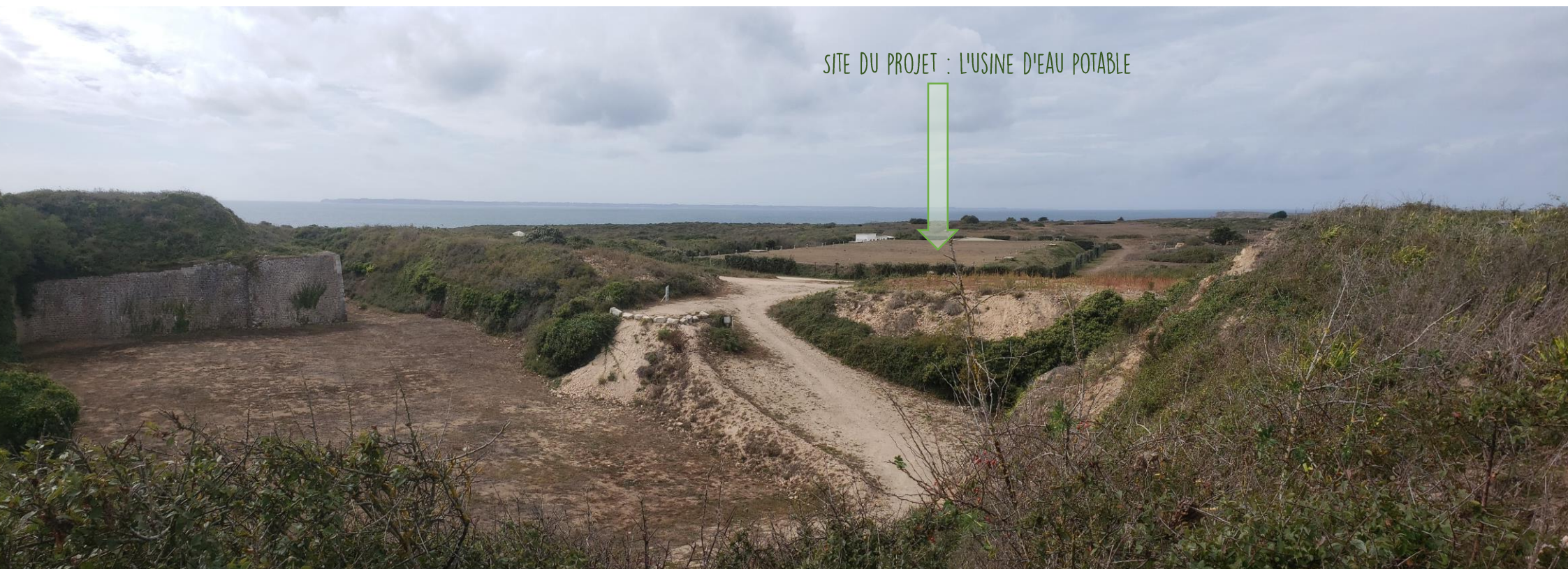
Vue sur le site du projet depuis le fort de Houat
