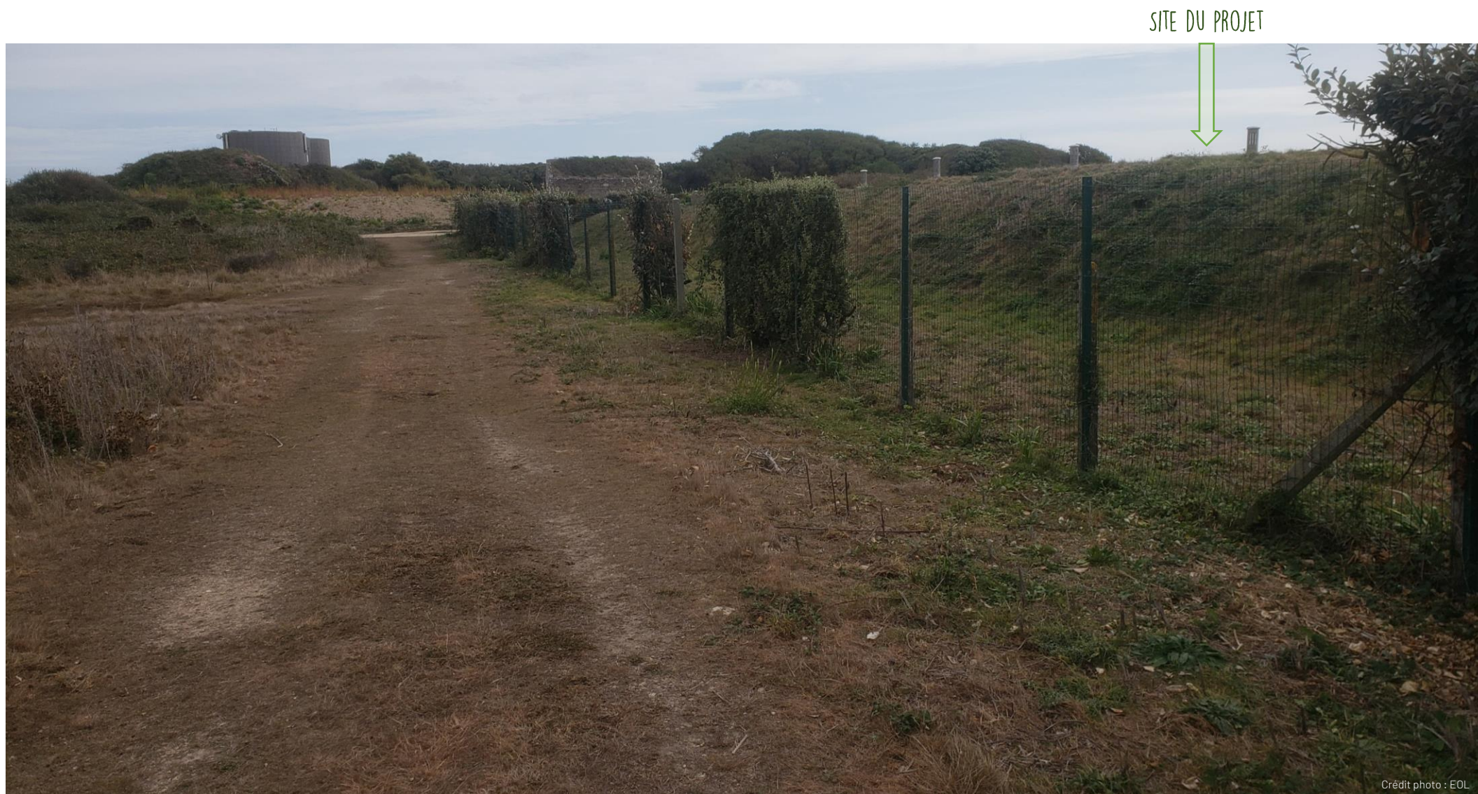
Vue vers le fort depuis le chemin qui longe le Nord du site. Sur la droite, les réserves d'eau potable semi-enterrées.
